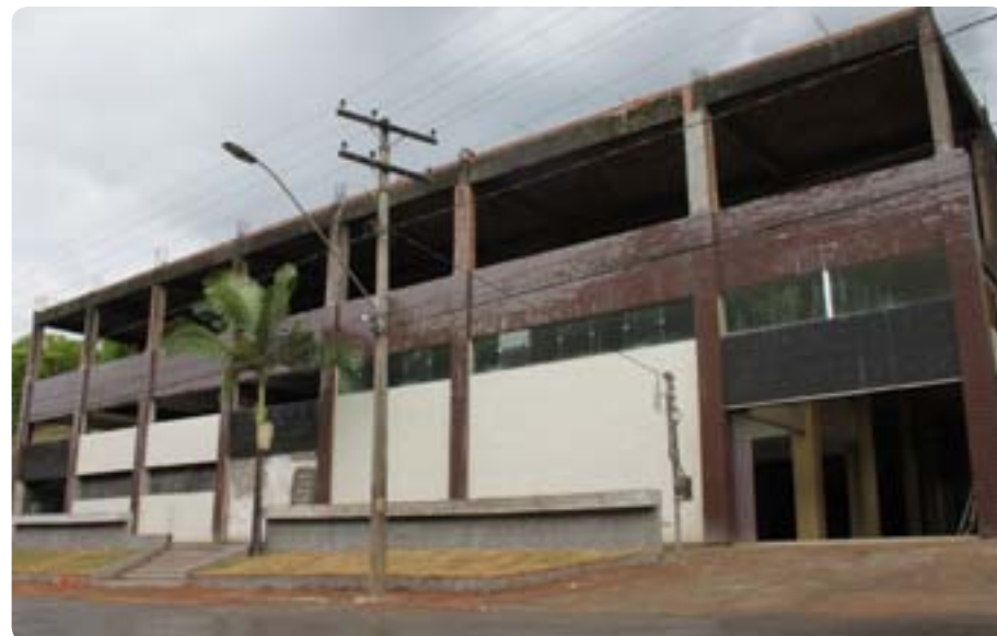
Obras no prédio, no bairro Baú, serão concluídas no fim do mês
