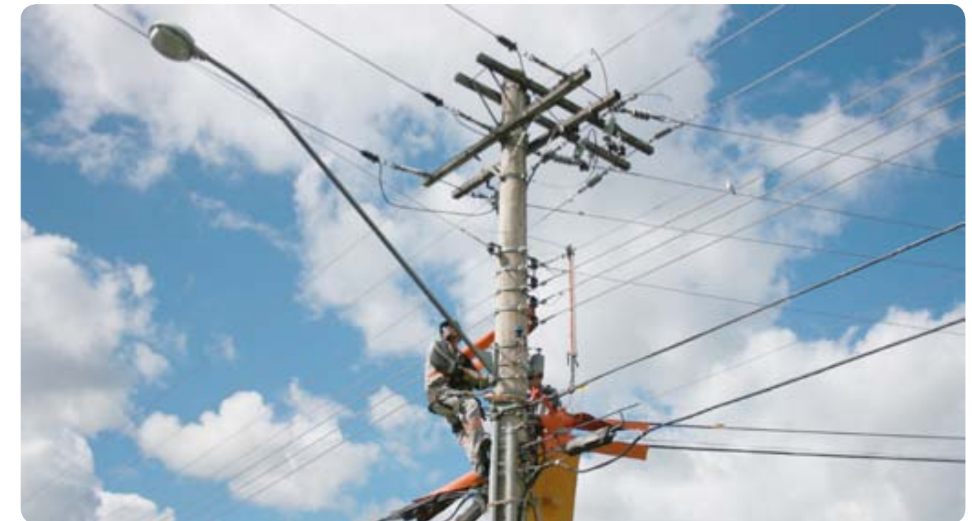
Novas luminárias são instaladas em todas as regiões da cidade
